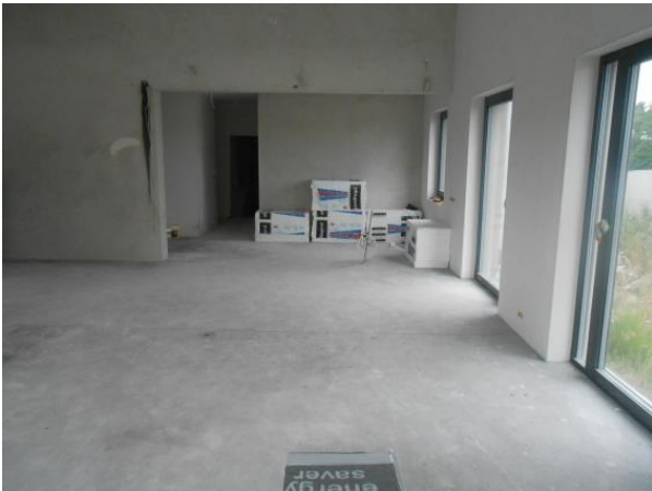
Fot. 11. Widok wnętrza budynku mieszkalnego
