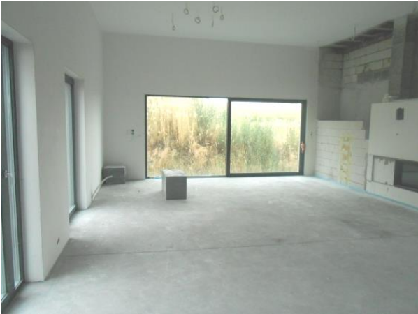
Fot. 9. Widok wnętrza budynku mieszkalnego
