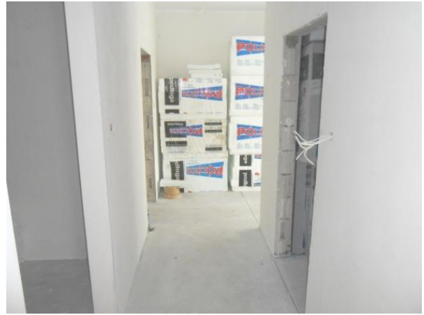
Fot. 18. Widok wnętrza budynku mieszkalnego
