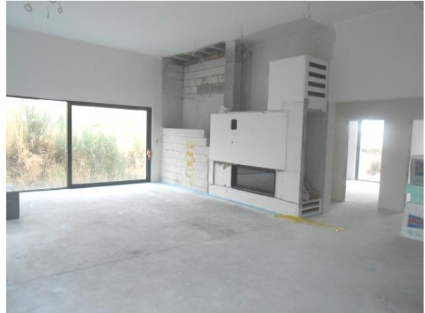
Fot. 10. Widok wnętrza budynku mieszkalnego
