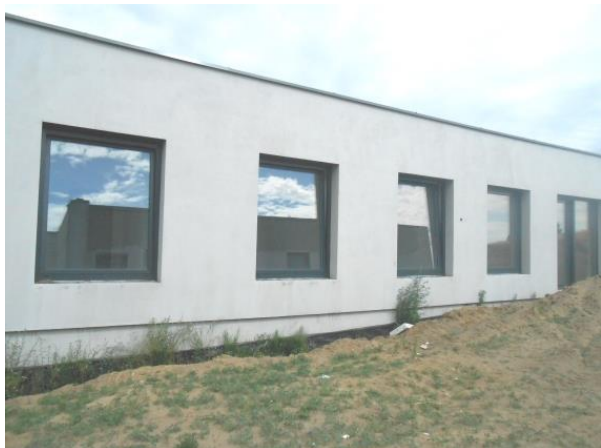
Fot. 3. Widok ogólny budynku mieszkalnego
