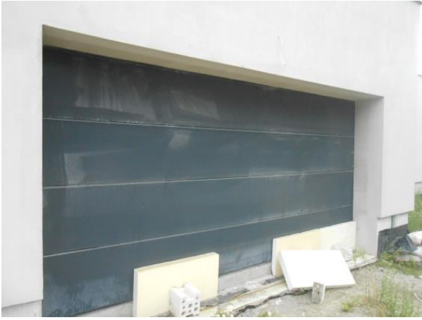
Fot. 7. Widok bramy garażowej
