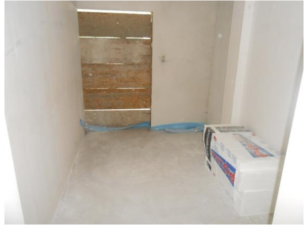
Fot. 16. Widok wnętrza budynku
