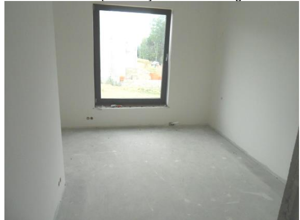
Fot. 14. Widok wnętrza budynku mieszkalnego
