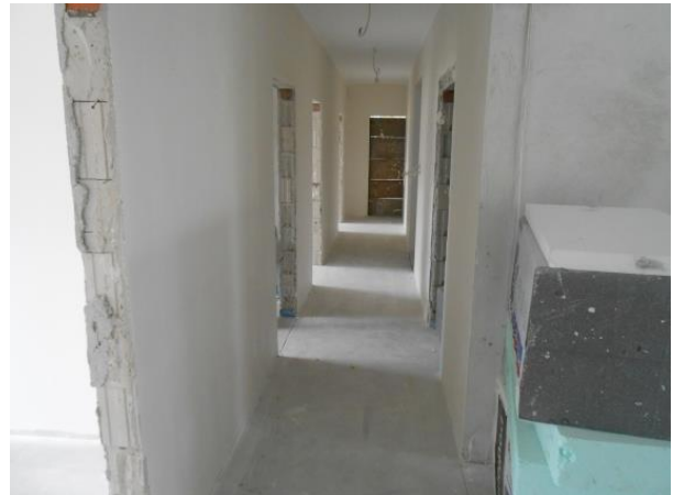
Fot. 12. Widok wnętrza budynku mieszkalnego
