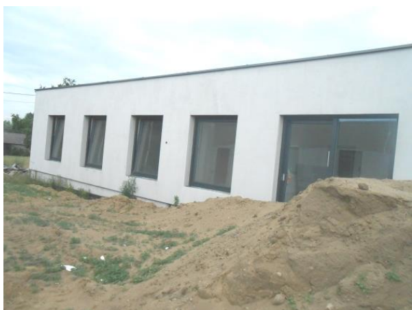
Fot. 5. Widok ogólny budynku mieszkalnego
