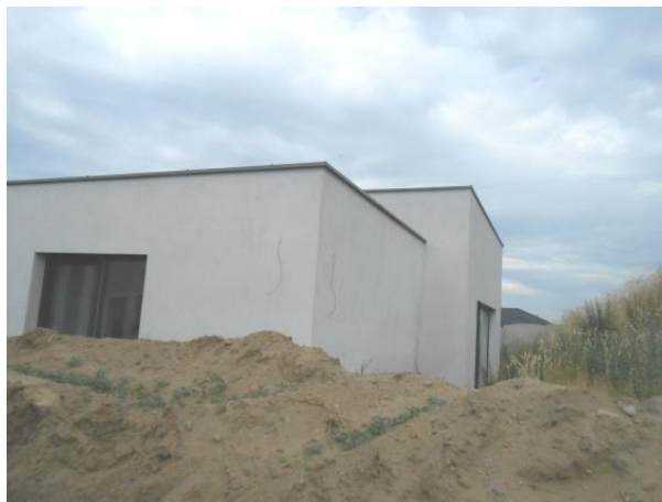
Fot. 4. Widok ogólny budynku mieszkalnego
