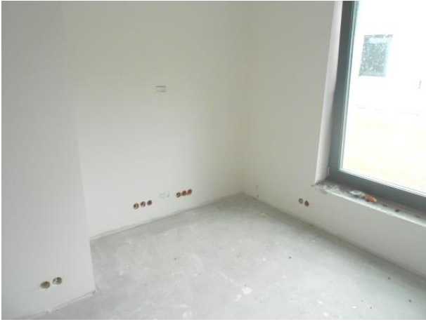
Fot. 15. Widok wnętrza budynku mieszkalnego
