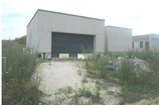
Fot. 2. Widok ogólny budynku mieszkalnego
