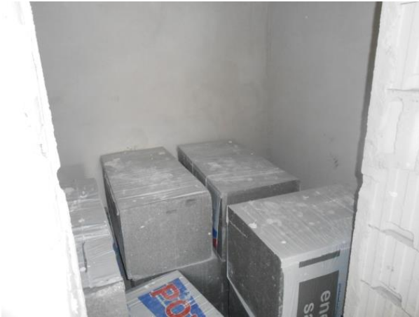
Fot. 17. Widok wnętrza budynku mieszkalnego
